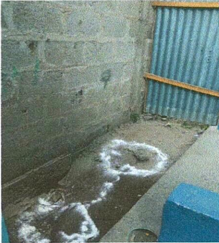
Foto 1: Mejoramiento e instalación de servicio sanitario para el nivel preprimario.
