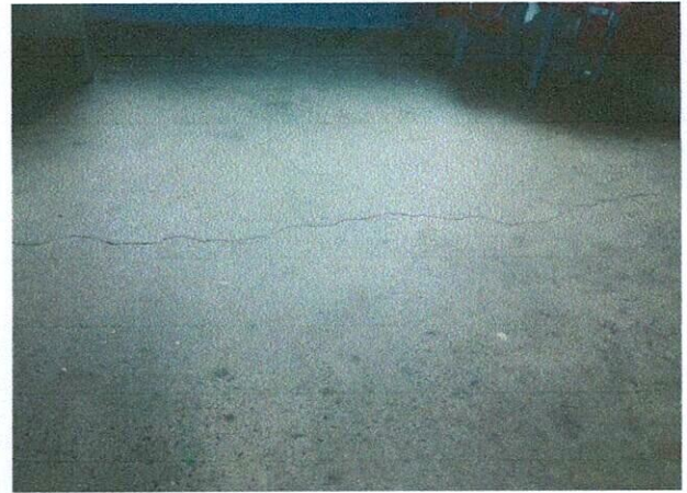
Foto 2: Mejoramiento de piso de tres aulas del nivel preprimario.
