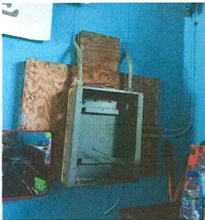
Foto 3: Mejoramiento y reparación de energía eléctrica del nivel preprimario.
